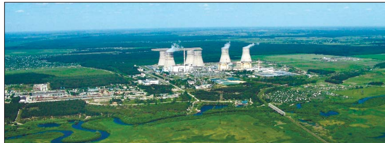
РАЕС з висоти пташиного польоту. Фото Володимира ДЬЯКОВА
