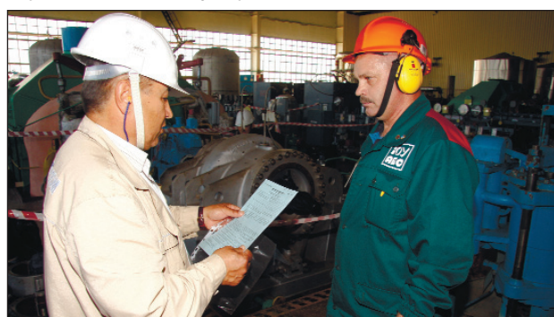
Обход рабочих мест, машзал энергоблока №2. Правильность выполнения работ и оформления нарядов проверяет старший инспектор по охране труда ООТ Владимир АМЕДОВ
