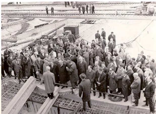
П.С. НЕПОРОЖНІЙ на будівництві Канівської ГЕС у 1968 році (на знімку — угорі)
