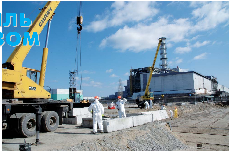
На снимках: сейчас на площадке ЧАЭС проводятся земляные работы по устройству котлованов под фундамент нового безопасного конфайнмента (арочная конструкция, которая будет «надвинута» на «саркофаг»).
