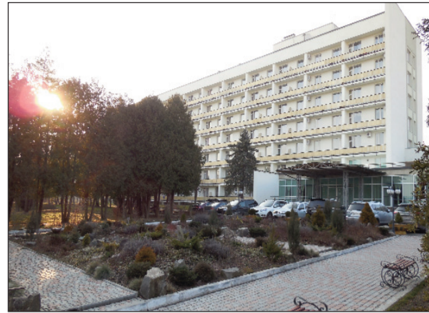
На снимке: Санаторий «Шахтер» в г. Трускавец
