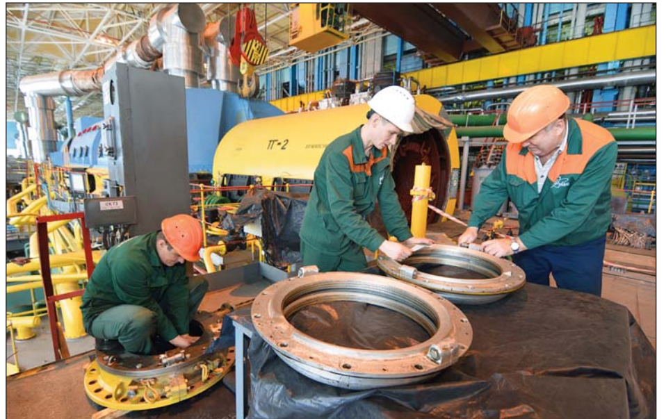
Рівненська АЕС: ремонтні роботи
